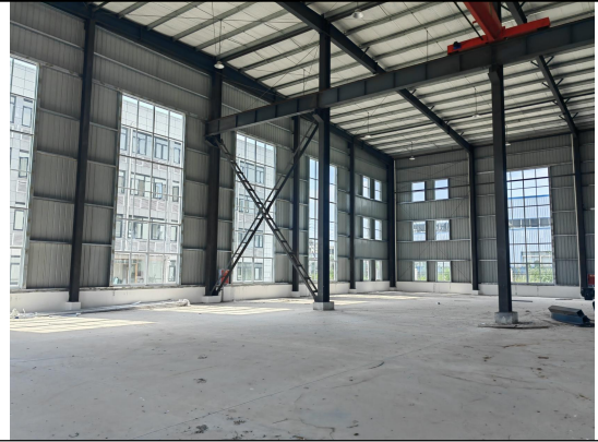
已建厂房内部现状
