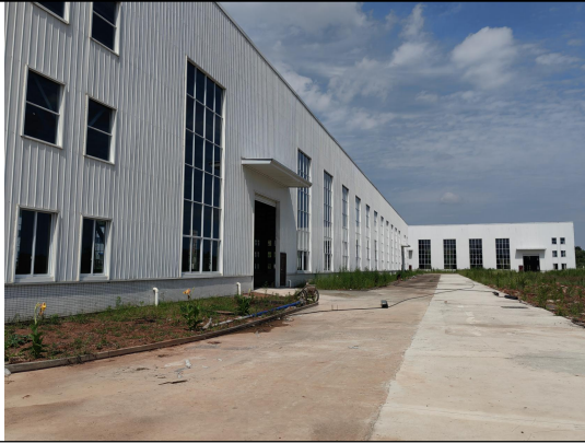
已建厂房外部情况
